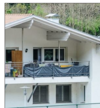
Das Geländer des Balkons wurde beschlagnahmt. ANDREAS KEMENATER
